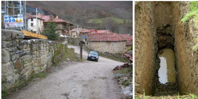
Fig. 25: Excavación, aledaña al muro de cierre perimetral, ejecutada para materializar el cajeadado de la explanada del vial existente al Este de la iglesia.
