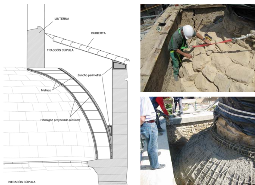
Fig. 39, 40 y 41: Refuerzo de hormigón proyectado.
